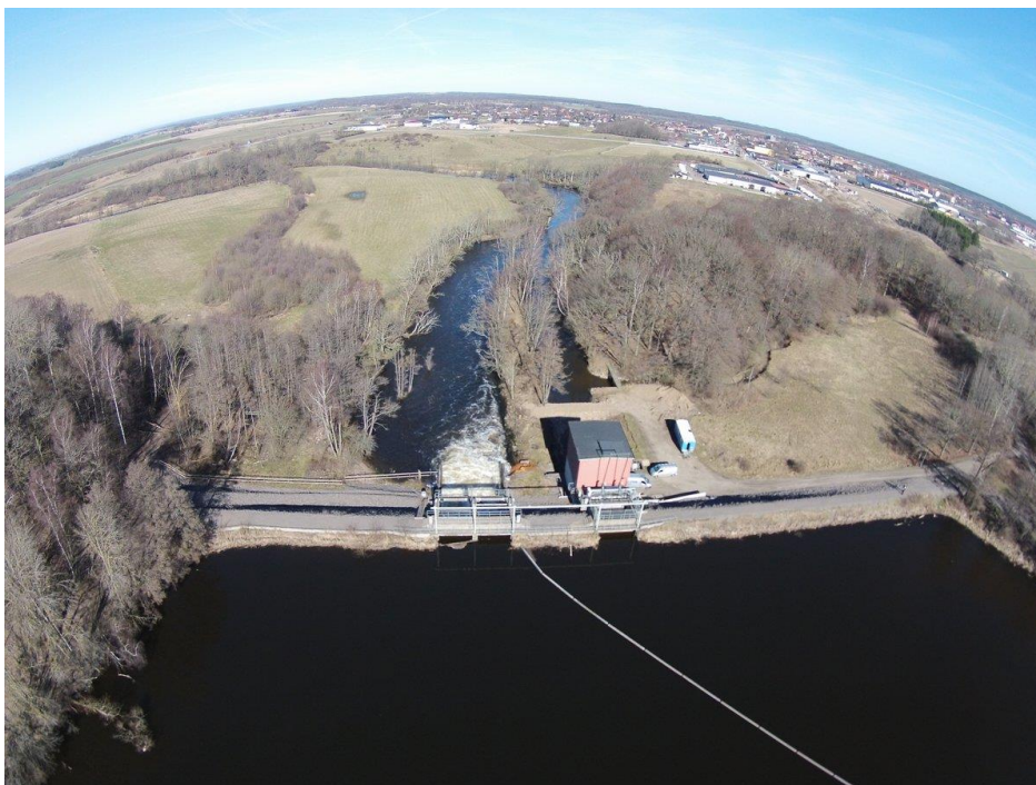
Figur 9. Nedströmsvy dammvallen och nedre delen av magasinet i Stackarp.
