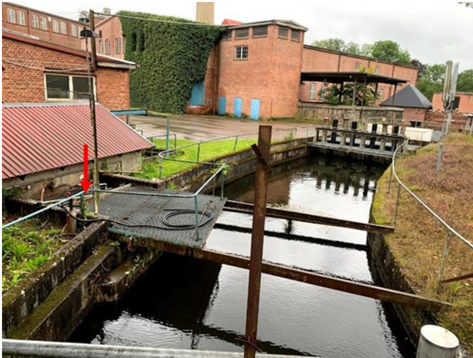
Figur 17. Intagskanalen med vy nedströms från bro vid Bruksallén. Processvattenintag till vänster (röd pil), avstängningsluckor, intag och kraftstation i bakgrunden.
