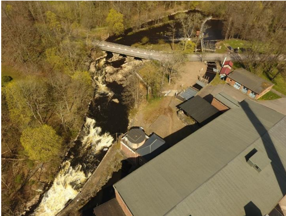
Figur 7. Uppströms vy av naturfåra, intag och dammbyggnad i bakgrund. Kraftstationen syns mitt i bild.
