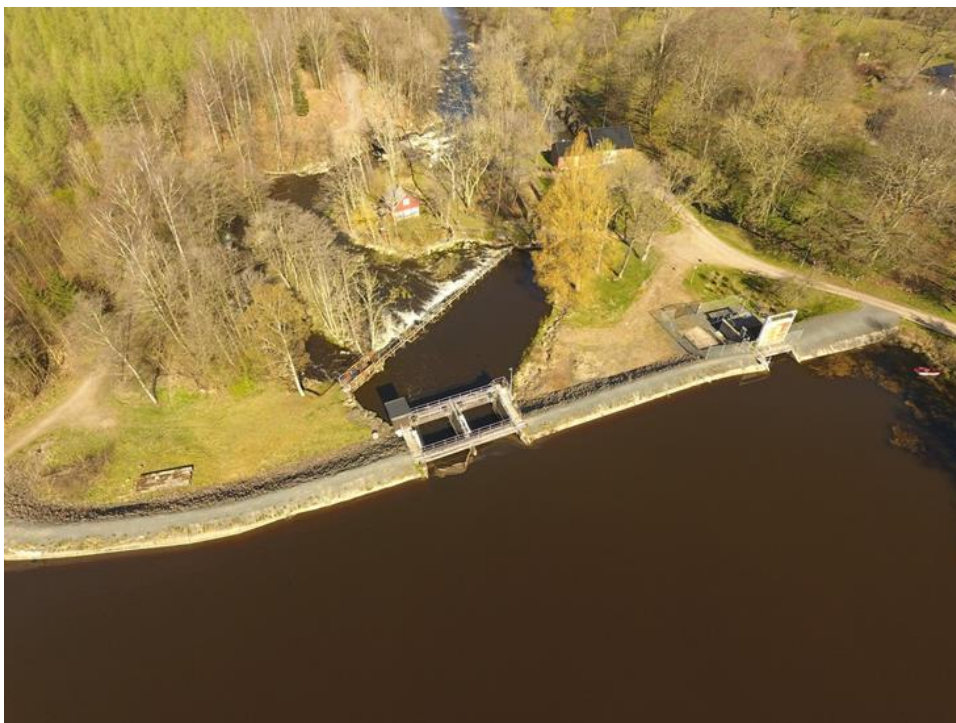
Figur 5. Nedströmsvy över anläggningen och nedre delarna av Forsmöllemagasinet. Foto: Rejlers.
